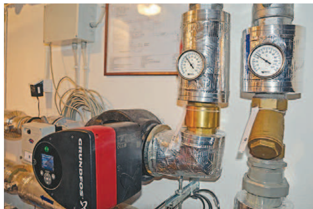
W pomieszczeniu piwnicy znajduje się sprzęt, który jest częścią hybrydy Fot. Grzegorz Siemieniuk
