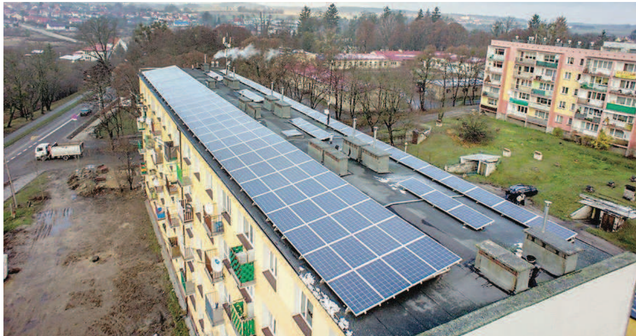
Instalacja fotowoltaiczna na dachu budynku w Szczytnie składa się ze 160 paneli Fot. Adam Gewartowski
