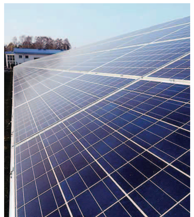
W ramach Programu Prosument można m.in. wybudować instalację fotowoltaiczną Fot. Grzegorz Siemieniuk
