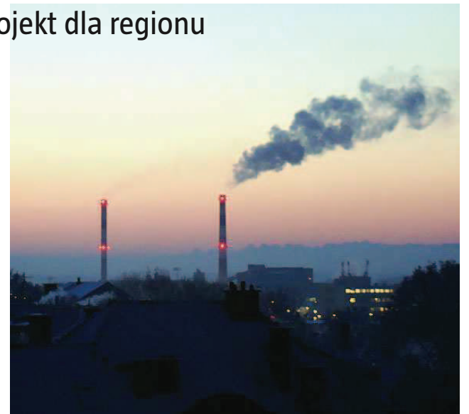
Realizacja projektu przyczyni się do wzmocnienia systemu pomiarowego jakości powietrza w naszym regionie
